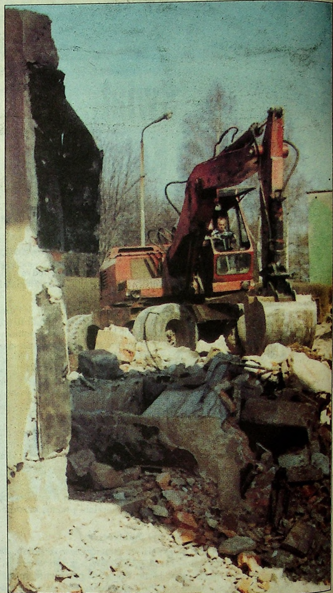
Trwa wyburzanie budynków kopalni.
