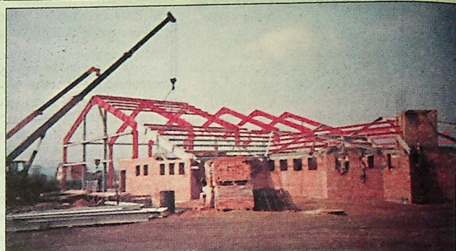
Budowa basenu na os. Słowiańskim
