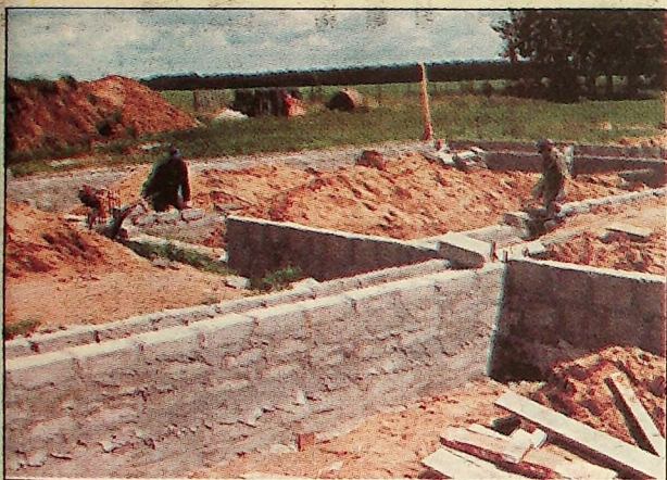
Budowa remizy w Warcie Bolesławieckiej
