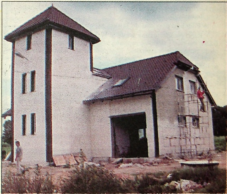
Budowa remizy i świetlicy w Jurkowie
