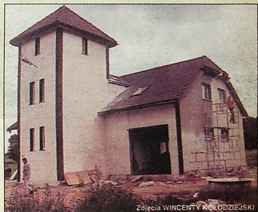
W tym roku część środków gminnych przeznaczono na remonty w szkołach i budowę świetlic. Jedną z nich powstała z remizą OSP w Jurkowie.
