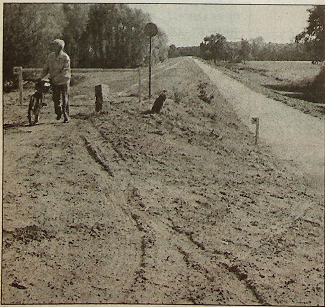
Wał po remoncie
