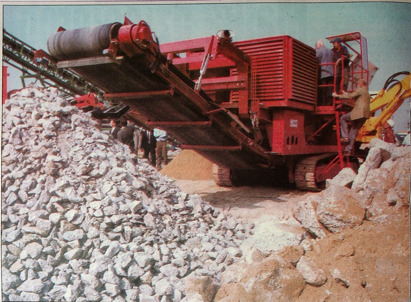
Częstocice koło Brzegu, na Opolszczyźnie, legmetowskie centrum recyklingu na 186. kilometrze autostrady. Płyty ze starej, wykonanej przed wojną nawierzchni są przerabiane na kruszywo, które jest wykorzystywane przy budowie nowej nawierzchni.
