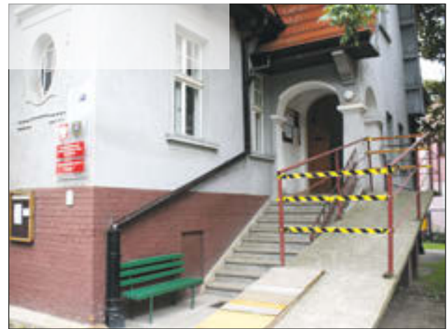
Gdy nowe okna i drzwi zostaną wstawione, w Domu Seniora rozpocznie się wymiana przełącznika wodociągowego i budowa zewnętrznej windy
