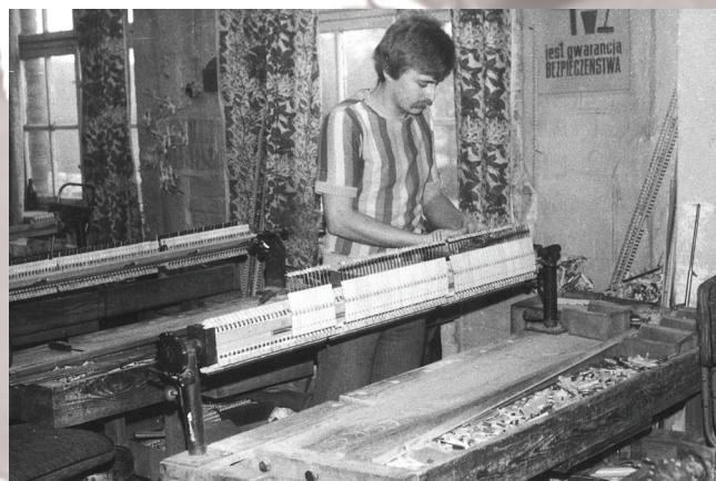
etapy montażu mechanizmu pianinowego zespół dźwigni głównej mechanizmu pianinowego
