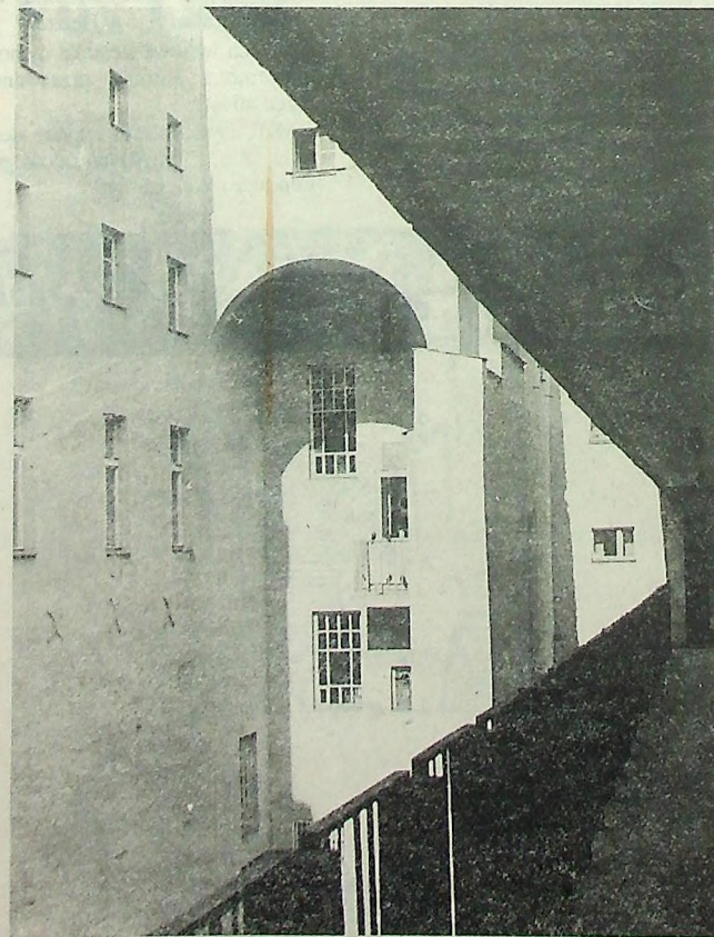
Fragment jakiego obiektu znajduje się na zdjęciu?
