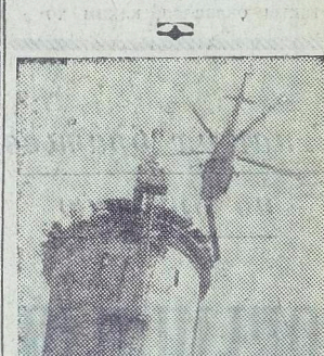
На территории ТЭЦ № 23 строители «Энергоспецстроя» возвели самую высокую в Москве 250-метровую трубу методом скользящей опалубки. Сейчас все монтажные работы завершены. Осталось снять с верхней части трубы около 40 тонн металлических конструкций и лесов, которые были необходимы при ее строительстве. Эту работу выполняли авиаторы-вертолетчики под командованием пилота С. Н. Попова из аэропорта «Шереметьево».
