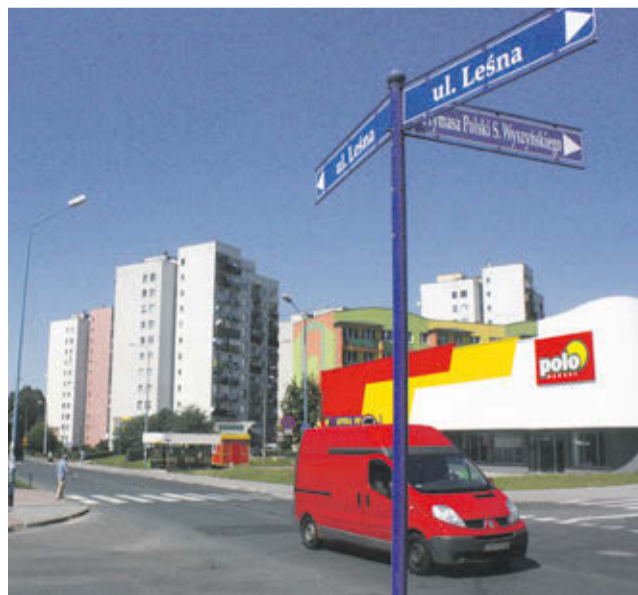
Przebudowana zostanie między innymi ulica Leśna
