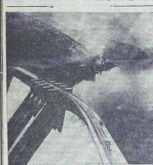
На снимке: гидроузел «Антонивановцы», составная часть гидроэнергетического каскада «Доспад-Вича».
