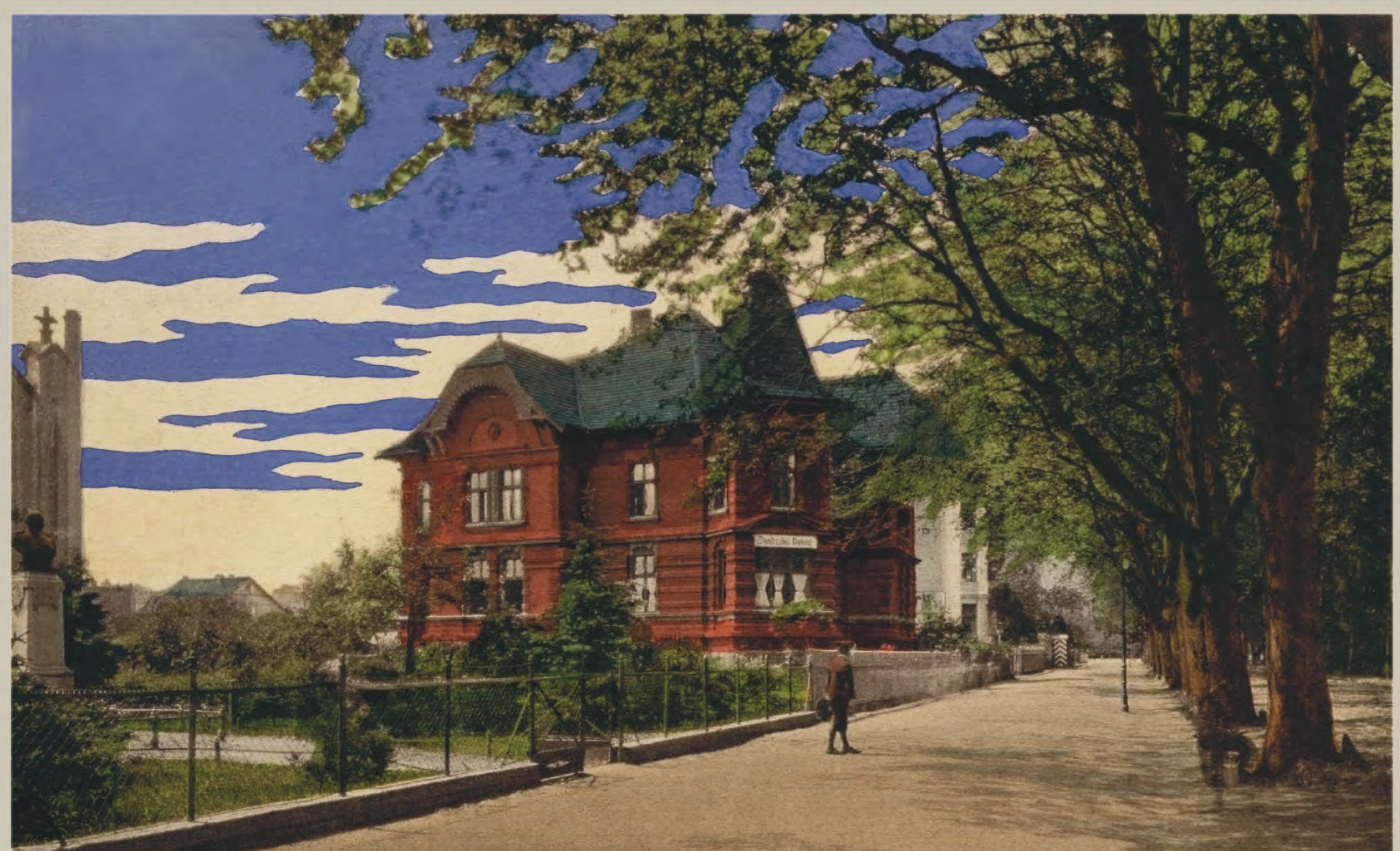
Miejskie gimnazjum. Obecnie prywatny budynek mieszkalny. W lewym rogu jest widoczny pomnik - popiersie Bismarcka na prostokątnym postumencie przed halą sportową. Obieg 02.05.1910 rok.
