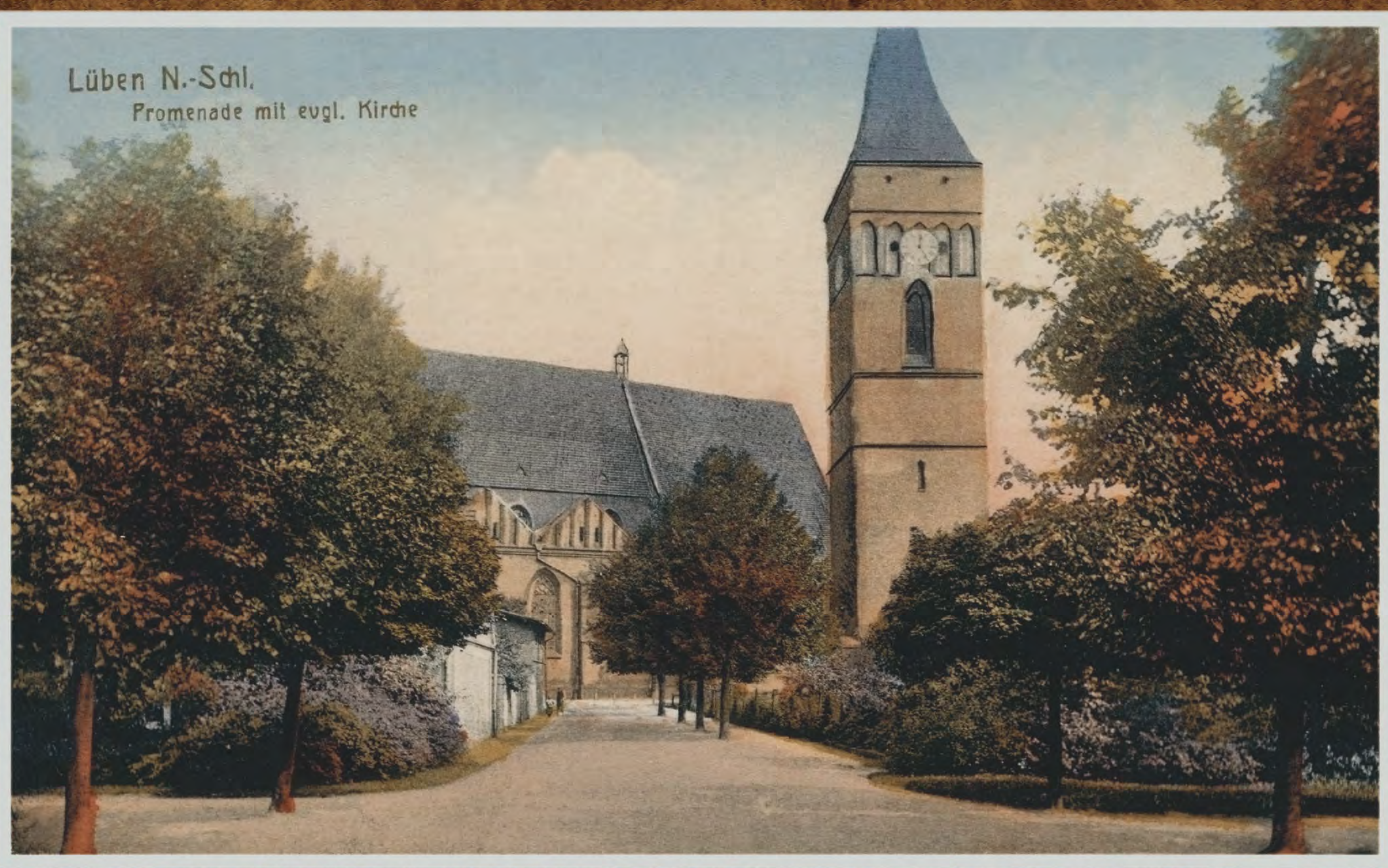
1917 rok. Widok na kościół ewangelicki z wolnostojącą dzwonnica, która była pierwotnie basztą obronną miasta. Świątynia, której budowa, przerywana działaniami wojennymi, trwała od drugiej połowy XIV do początków XVI wieku. Obecnie Kościół parafialny pw. Matki Bożej Częstochowskiej - usytuowany przy ul. Kołłątaja. W środku przejście do promenady szkolnej.
