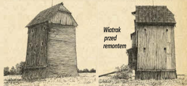
Wiatrak po ubiegłorocznym remoncie
