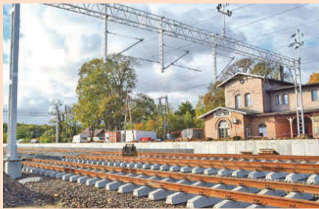
Remont linii nr 289 wciąż trwa, a jeśli wykonawca prac będzie miał kłopot z terminowym zakończeniem robót, rozkład jazdy może ulec zmianie
