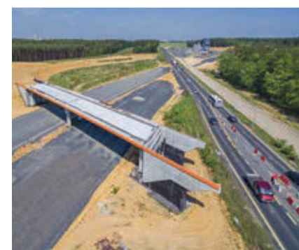
Placów budowy całodobowo pilnować ma firma ochroniarska
