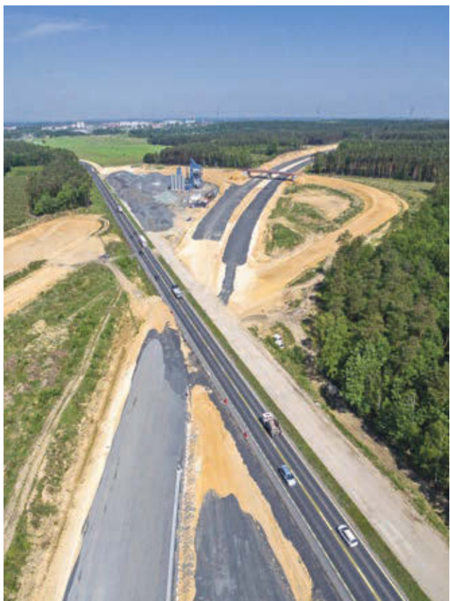
Nowo wybranemu wykonawcy pozostanie do ukończenia 25 procent prac, które pozostały na tym odcinku
