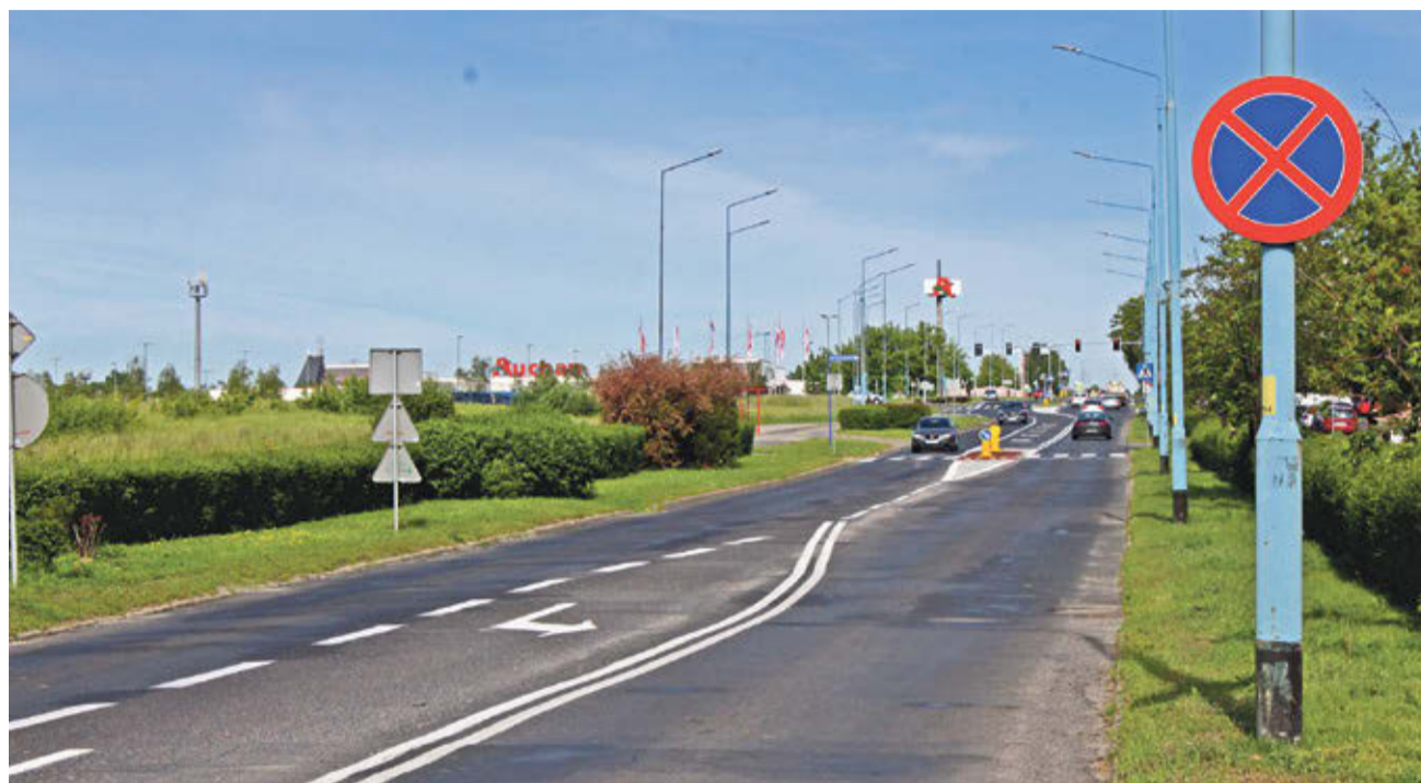
Na początek wyremontowany zostanie fragment od skrzyżowania z ulicą Leszczynową do Jarzębinowej
