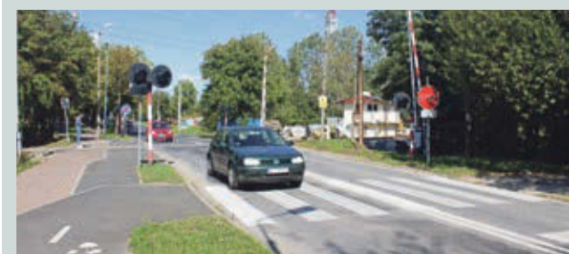
Przejazd ma być zamknięty przez około dwa tygodnie
