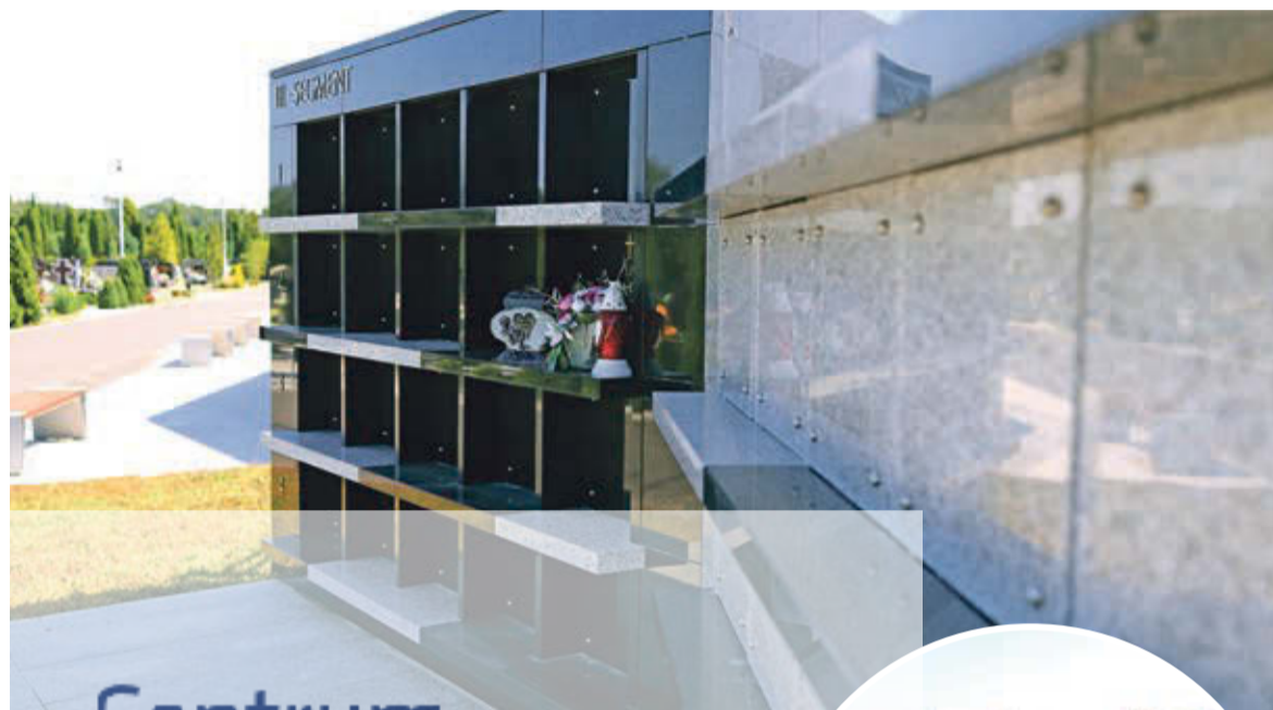
Kolumbarium miasto wybudowało w ubiegłym roku
