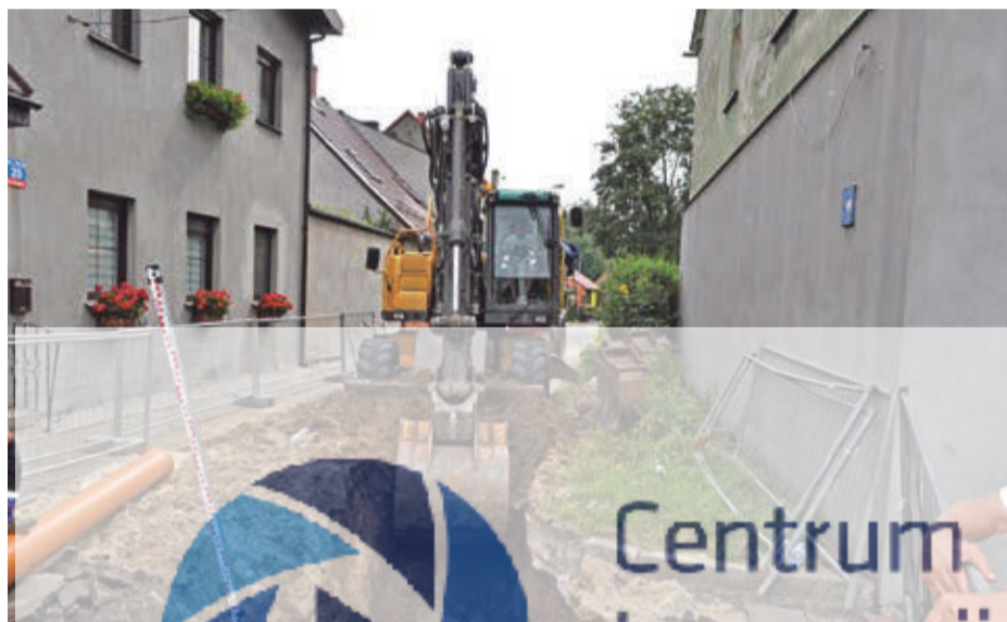
Budowlańcy prowadzą prace w obrębie ulicy 1 Maja
