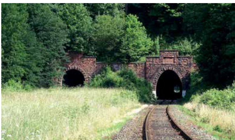
Źródło: Fot. Przemysław Dominas. Rycina 12. Obydwa portale tunelu pod górą Sajdak od strony południowej (Głuszyczy) oblicowano rustykalnie zdobionymi blokami czerwonego piaskowca
