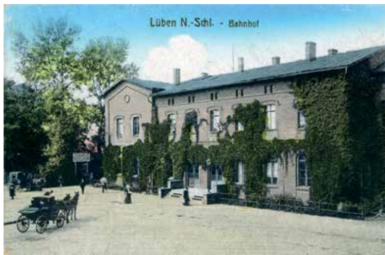
Źródło: lueben-damals.de. Rycina 2. Budynek stacji kolejowej w Lubinie
