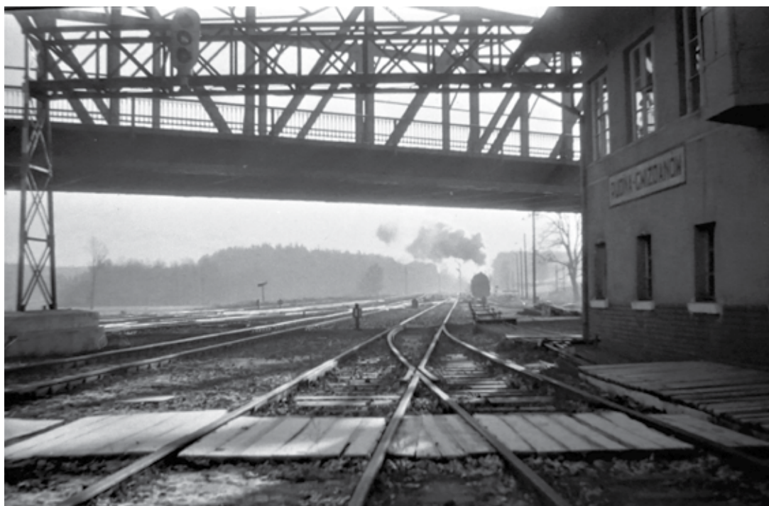
Rycina 7. Nastawnia dysponująca wraz z galeryjką, na którą mógł wejść dyżurny ruchu, aby dokładnie rozeznaczyć sytuację na stacji. Galeryjka ta jest obecnie zdemontowana. Widoczny jest wiadukt drogowy i w dali jeden z ostatnich pociągów wjeżdżających na stację od strony Polkowic (pierwsza połowa lat 60.). Fot. Z. Kletowski
