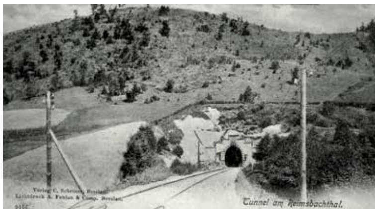
Źródło: Zbiory prywatne autora. Rycina 11. Tunel pod górą Sajdak na szlaku Jedlina Zdrój–Głuszycza przed podjęciem budowy drugiej komory
