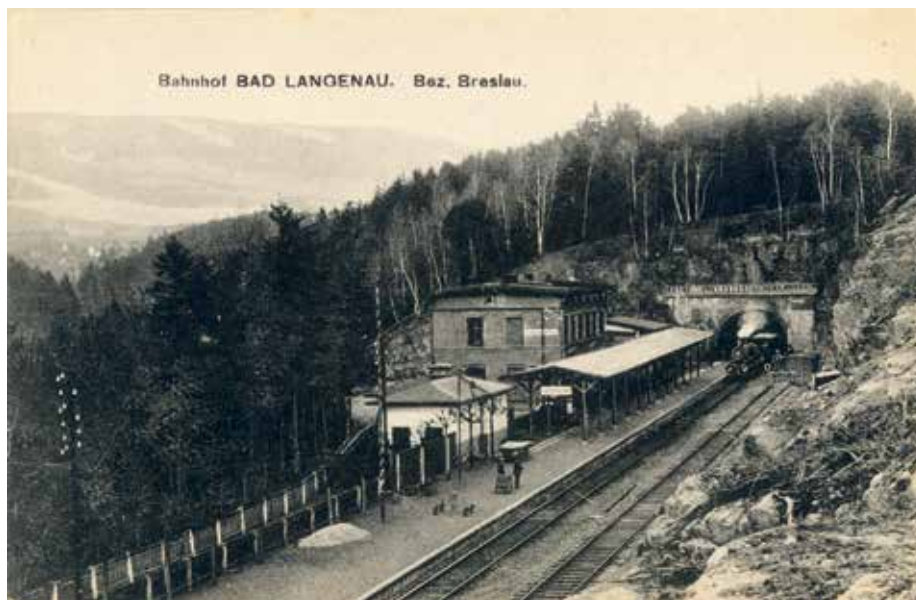
Źródło: Zbiory prywatne Adama Pacześniaka. Rycina 7. Poczłtówka ukazująca tunel w Długopolu-Zdroju w Górach Bystrzyckich wraz z wtórnie wzniesionymi zabudowaniami stacyjnymi
