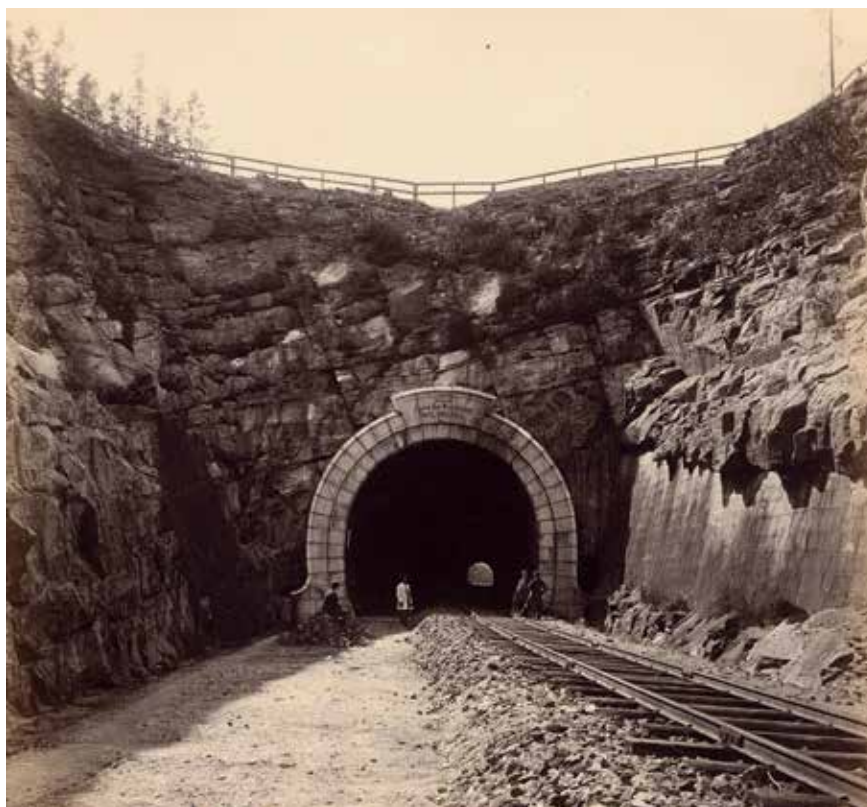
Źródło: Architekturmuseum Technische Universität w Berlinie. Rycina 5. Tunel pod górą Brzezinka w Wałbrzychu (310 m) po oddaniu do ruchu w 1866 r. Portal z jasnego piaskowca z napisem: Erbautunter Regierung Wilhelms I (Zbudowano za panowania Wilhelma I)
