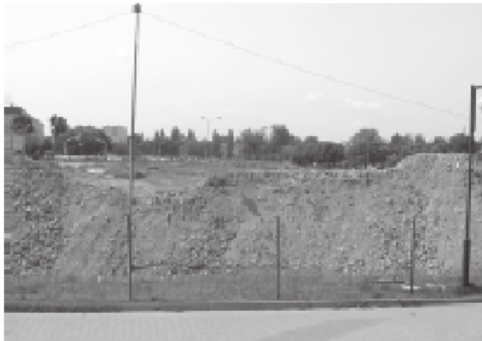
Teren budowy Galerii Cuprum w Lubinie
