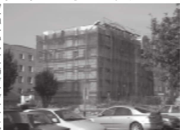
Jeden z modernizowanych bloków na Ustroniu IV
