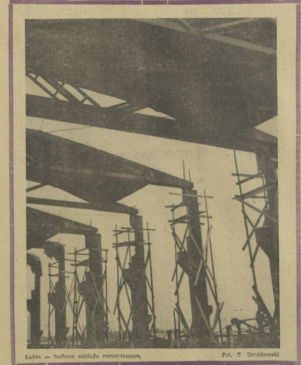
Lubin — budowa zakładu remontowego. Fot. T. Drankowski
