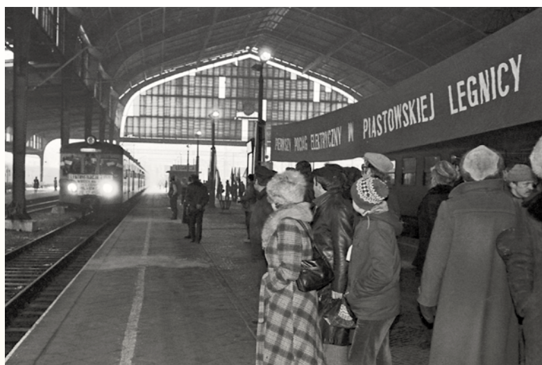
Wjazd pierwszego pociągu elektrycznego na stację w Legnicy. Po prawej transparent: „Pierwszy pociąg elektryczny w piastowskiej Legnicy”, 28 grudnia 1984 r.
