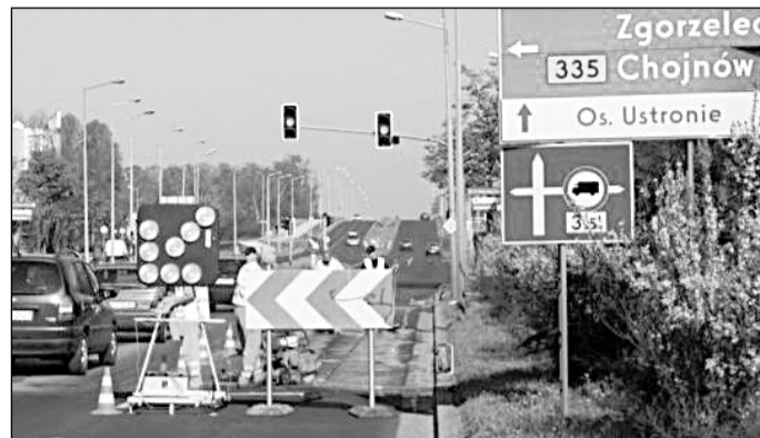
Prace nad nowymi światłami potrwają do końca maja
