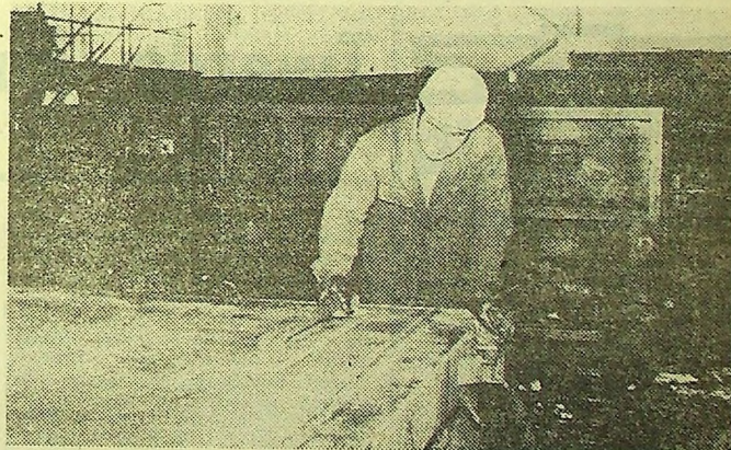
Tadeusz Kunat wyrównuje powierzchnię elementów dachowych.
