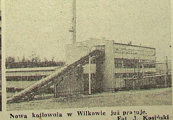
Nowa kotłownia w Wilkowie już pracuje. Fot. J. Kosiński
