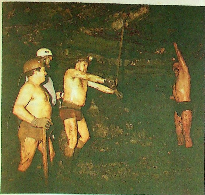
Brygada Franciszka Paździora (pierwszy z prawej) przy zabudowie przodka
