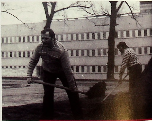
Hutnicy z Legnicy pomagali przy budowie Centrum Zdrowia Dziecka w Warszawie. Na fot. Andrzej Burzyński.
