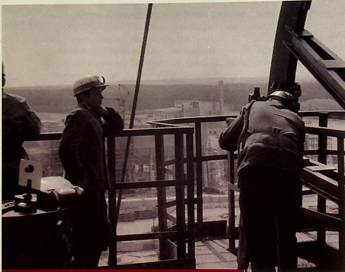
Grupa miernicza ZG Polkowice przy ustawianiu kół linowych maszyny wyciągowej na szybu P.I. Na zdjęciu od lewej: Bolesław Pawłowski, Jan Jurczenko i przy teodolicie Paweł Boryk.
