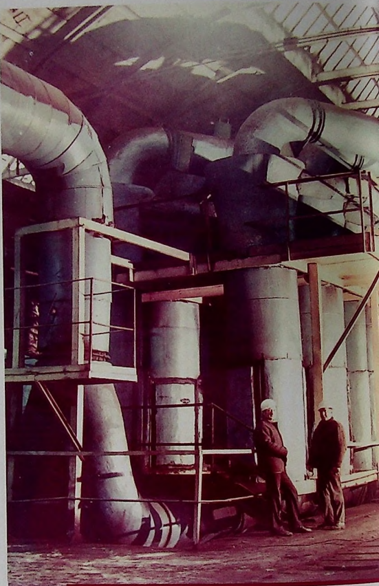
Tadeusz Stawski z kolegą przy cyklonach przeciwbieżnych, służących do odpylania gazów w procesie suszenia koncentratu. Lata 80.
