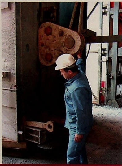
Jerzy Stępień podczas prac związanych z wymianą skipu - szyb R-II.
