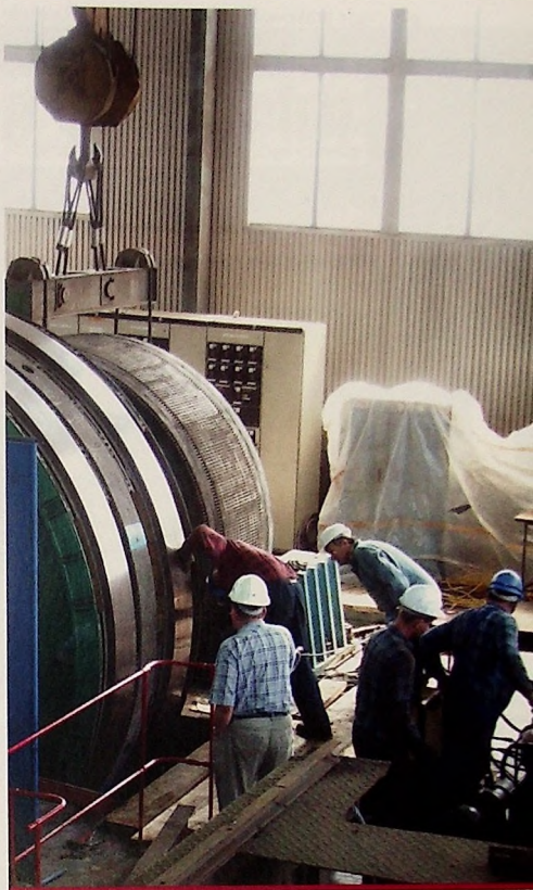
Jerzy Stępień nadzoruje modernizację maszyny skopowej na szybie R-I.
