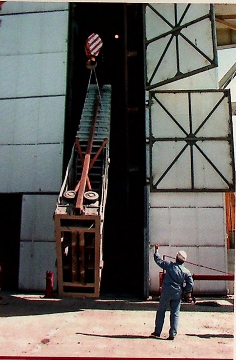
Jerzy Stępień dogląda wymiany skipu o udźwigu 33 ton w szybie R-II.
