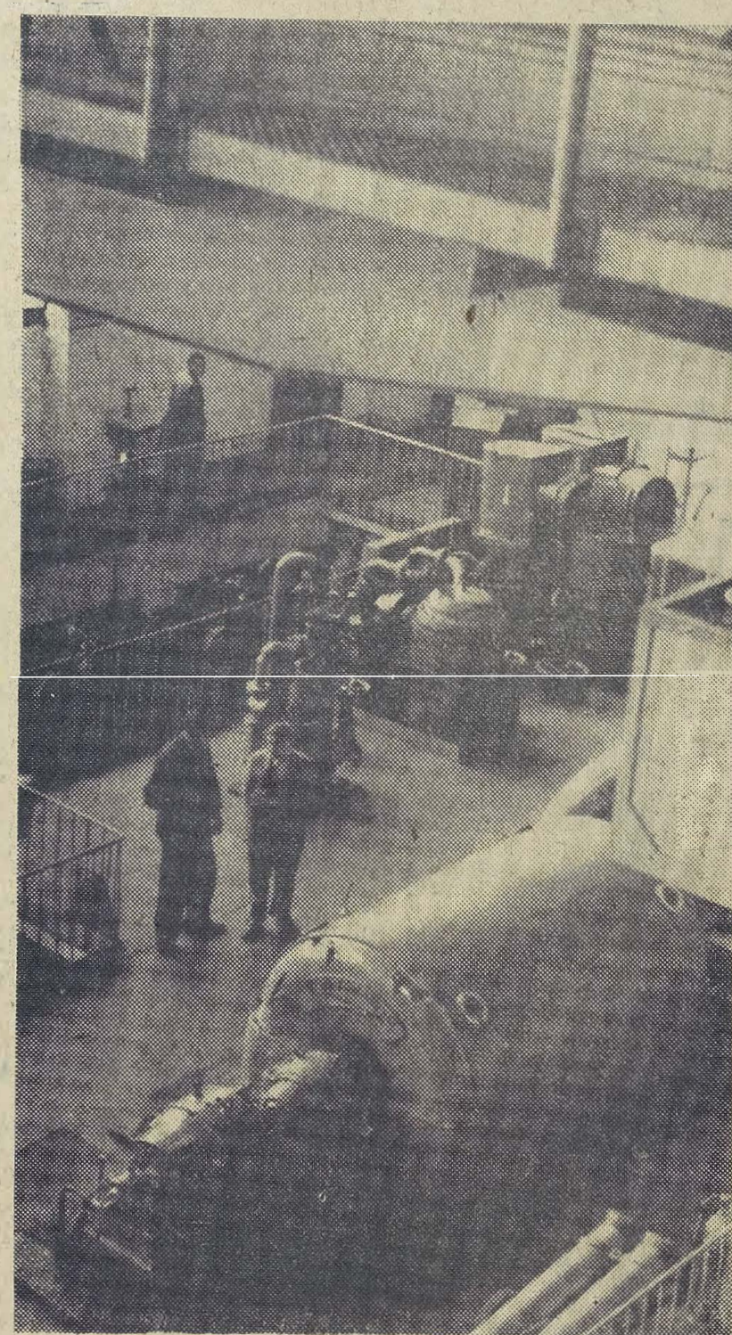
Huta Miedzi — elektrociepłownia.
