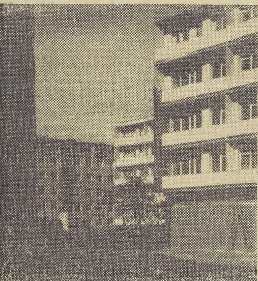
Budowa osiedla mieszkaniowego do użytku. Trwają ostatnie prace przy ul. Artyleryjskiej została zakończona. Wszystkie bloki oddano
