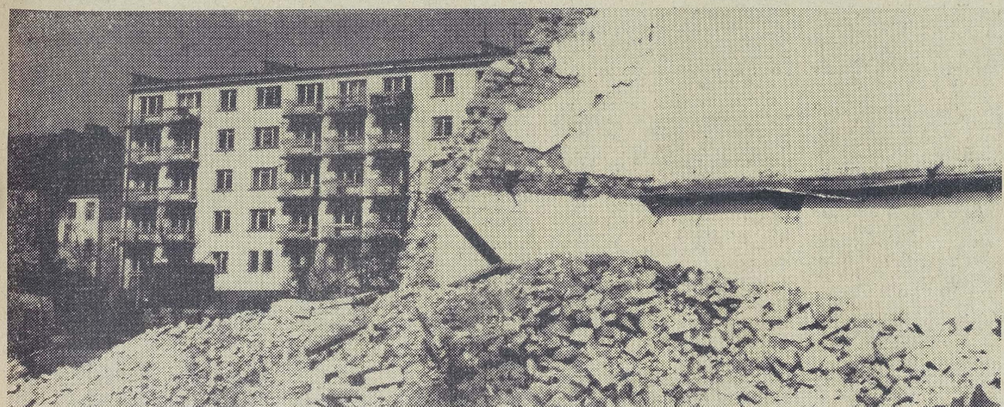
Lubin. Ulica Spacerowa. Rozbiórka starych domów gdzie wkrótce powstaną nowe.
