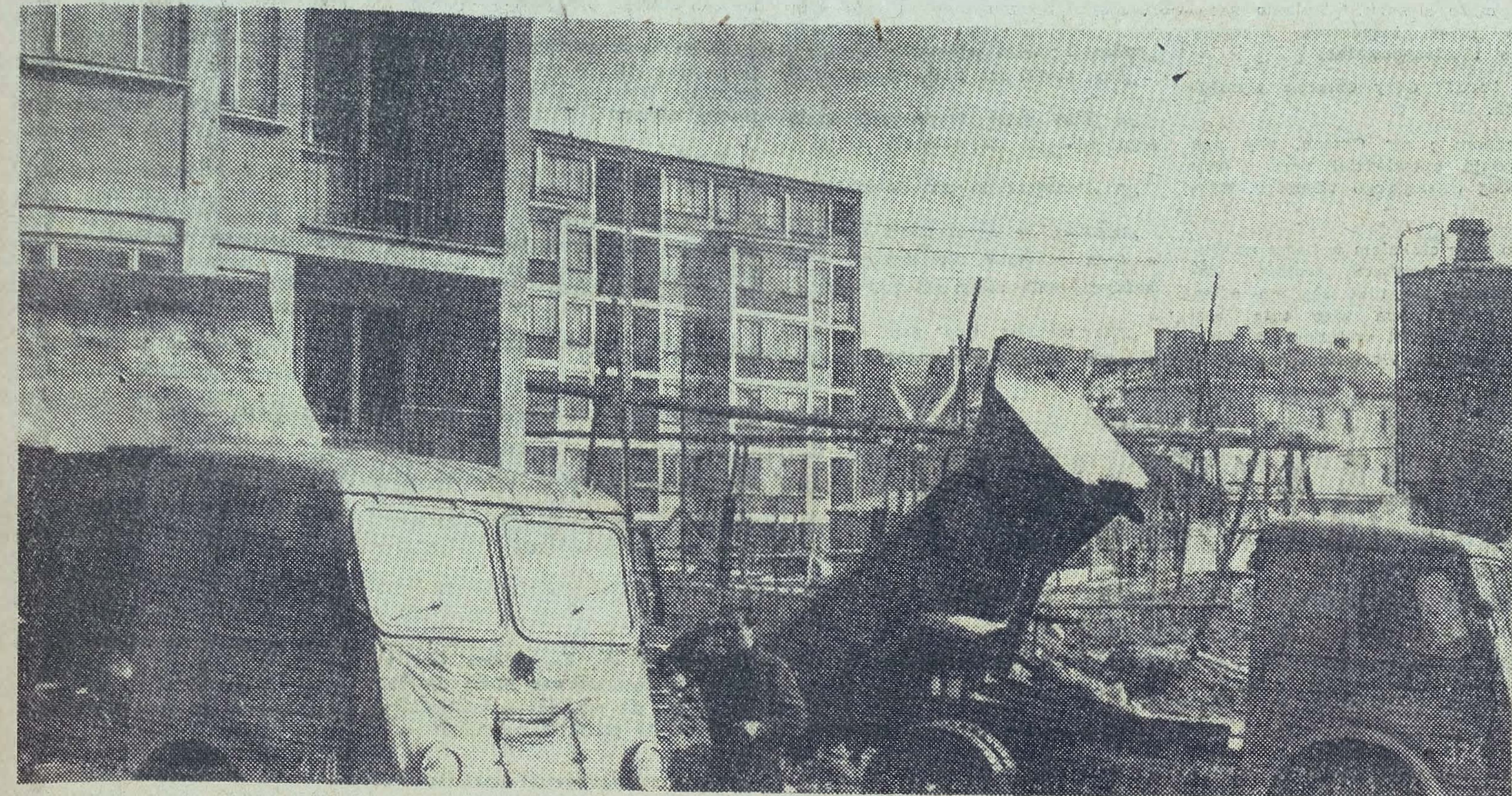
Budować więcej i taniej można tylko metodami uprzemysłowionymi. Na zdjęciu budowa placu Wolności w Lubinie.
