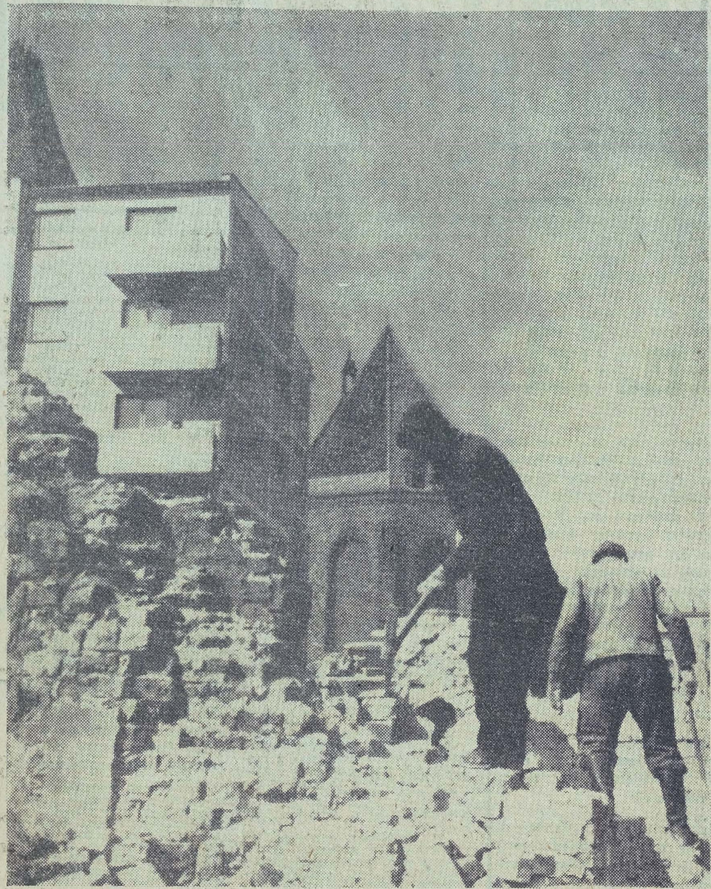
LUBIN. Ul. Wąska — rozbiórka starych domów.
