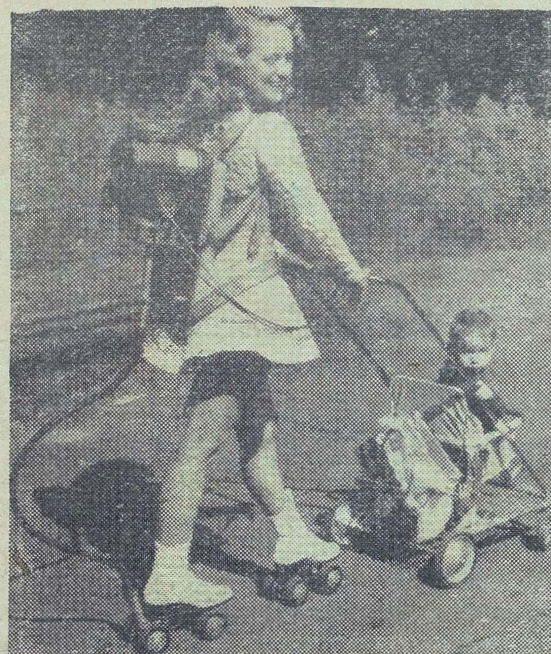
Janet Slaughter z Chicago odbywa spacer z dzieckiem jeżdżąc na zmotoryzowanych wrotkach, których silnik, noszony na plecach, zawiera paliwo, wystarczające na ok. 100 km przy szybkości ok. 30 km na godzinę. Fot. CAF
