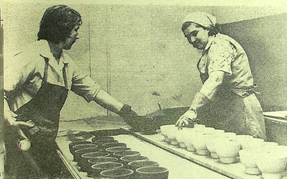
Gotowe brudne szklivo w niczym nie przypomina tego, co decyduje o urodzie ceramiki, uzyskuje się dopiero podczas półdobowego wypieku. Nim jednak wyrób trafi do pieca ym szklivem pokryją go Bolesław Hucal i Michalina Zak.
