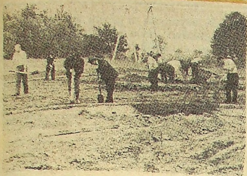
LUBIN. Ekipa ZRM KGHM buduje parking w sąsiedztwie ścieżki zdrowia, którą w zagajniku koło osiedla Przysięśle wytyczali pracownicy ZG „Lubin” ZRG i „Defilu”.
