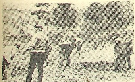
MŚCIWOJÓW. Budowano tu m. in. kort tenisowy, boisko sportowe i fundamenty pod remizę strażacką.
