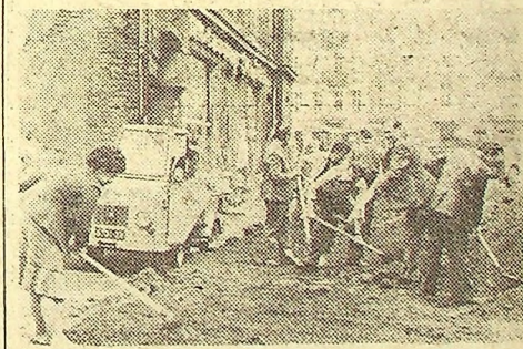
LEGNICA. Członkowie Egzekutywy KW PZPR i kierownictwo instancji wojewódzkich ZSL i SD pracowali przy budowie chodnika ul. Wrocławskiej.
