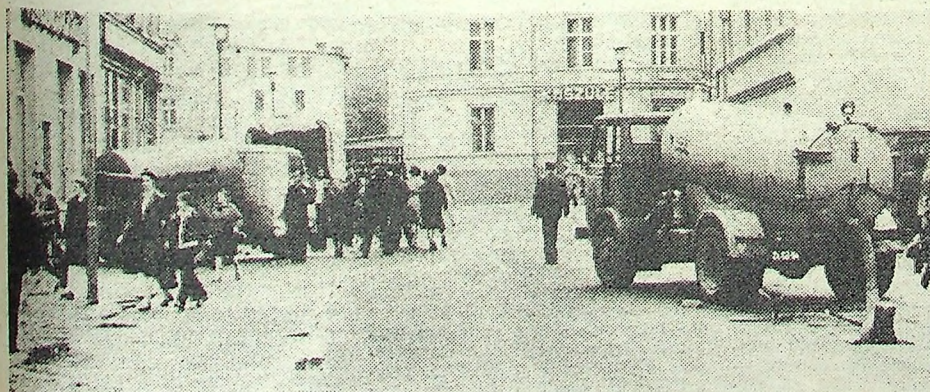
Ciągłe jeszcze wypompowuje się wodę z piwnic.
