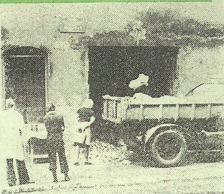
Trwa porządkowanie magazynów i sklepów. Na zdjęciu: Usuwanie zniszczonych artykułów chemicznych z magazynu WSS „Społem” przy ul. Roosevelta.
