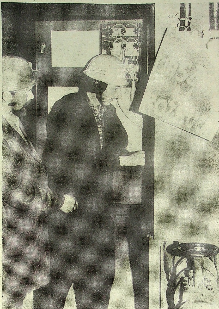
Budowa Huty Miedzi „Głogów 2” na finiszu. Kompresorownia. Rozruchu angielskiej sprężarki dokonują (od lewej) Antoni Walkowiak i Bogusław Jemiolo.
