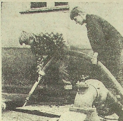
Ekipy monterów WUT przepłukują zamulone otwory kabli telekomunikacyjnych.
