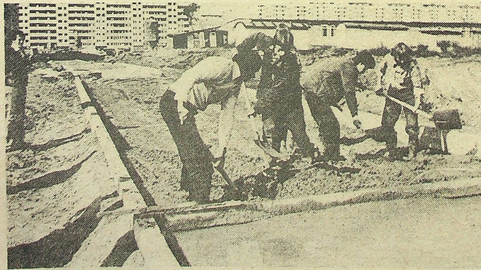
Kilkadziesiąt metrów nowej, betonowej nawierzchni jest dziełem grupy ZSMP-owców kierowanej przez Wiesława Galeza.
