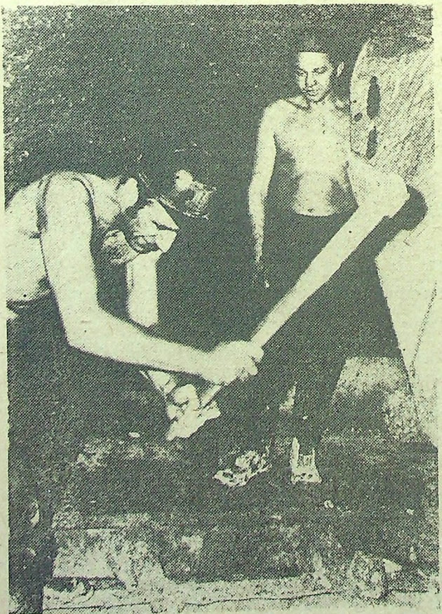
Wydobywana przez PBKR Częstochowa ruda wędruje właśnie na transporter i dalej do skipu. Na kracie, dokąd dostarczany jest urobek z przodków, zastajemy operatora joja Stanisława Salbierza i Zbigniewa Sokółowskiego, który rozbije co większe bryły, aby przeszły przez oka kraty.
