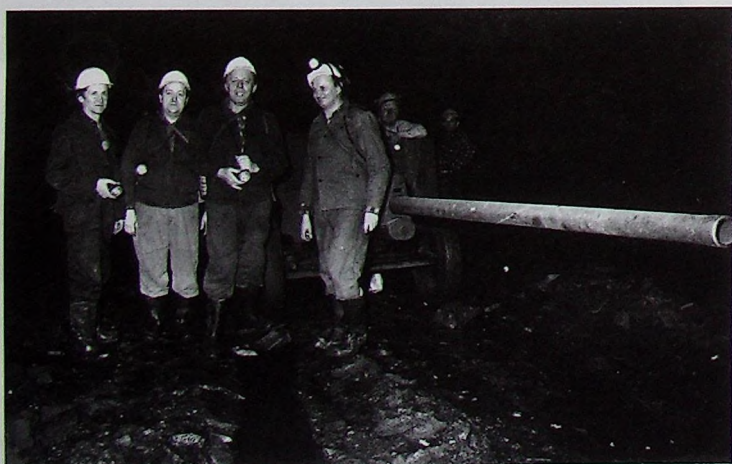
Armaty pod ziemią? Dziś brzmi to jak żart, ale przed laty próbowano pociskami kruszyć górotwór. Zdjęcie wykonano w kopalni „Lubin” w latach 70.
