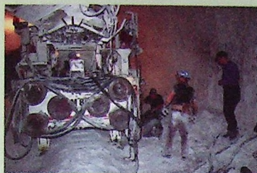
Konserwatorzy sprzętu wymontowują z kombajnu solnego uszkodzony silownik
