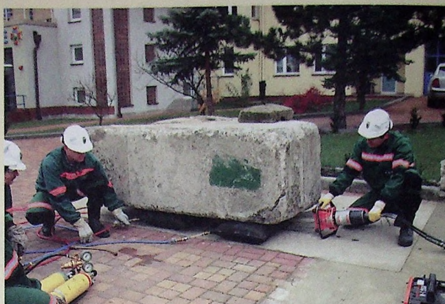
Przy użyciu rozpieraka pod głaz podkłada się poduszki powietrzne. Umożliwiają podnoszenie przedmiotów o ciężarze do 67 t
