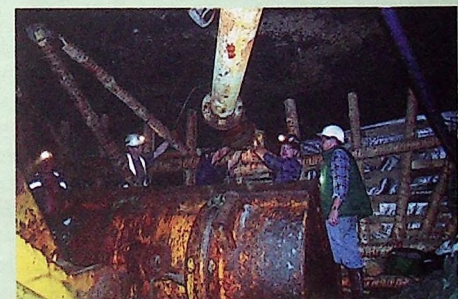
Pracami przy budowie tamy podsadzkowej na Oddziale A-2 kieruje sztygar Daniel Zawisza
