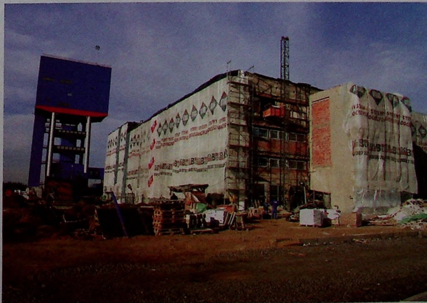
Trwają prace wykończeniowe budynku administracyjno-socjalnego
