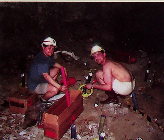
Robert Izdebski i Piotr Bukraba w trakcie ładowania otworów strzałowych szybiku
