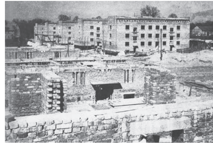
Budowa nowych bloków mieszkalnych przy ul. Kościuszki, ok. 1960 r. (A. Czelny, Między Odrą a Nysą, Ossolineum, Wrocław 1961)
