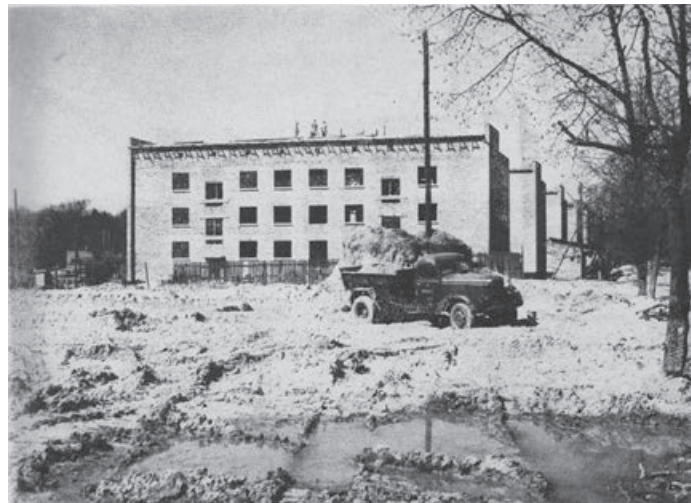
Budowa nowych bloków mieszkalnych przy ul. Kościuszki, ok. 1960 r. (A. Czelny, Między Odrą a Nysą, Ossolineum, Wrocław 1961)
