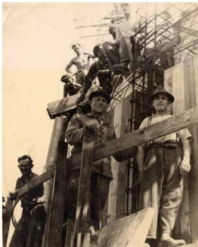
Ludzie zatrudnieni przy budowie wieży ciśnień w Legnicy
