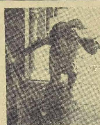
Nienależycie zabezpieczony otwór piwniczny przy nowo odrestaurowanych Kramach Śledziowych w Rynku (tuż przed naszą redakcją) stanowi nową pułapkę na przechodniów.
