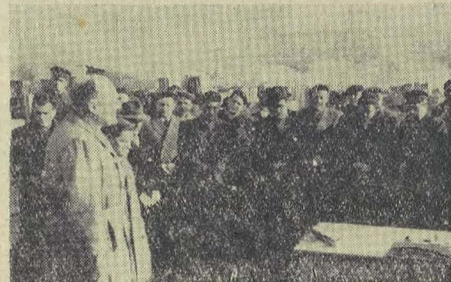
1 sierpnia 1959 roku na plac budowy Szkoły Tysiąclecia przy ul. 22 Lipca wjechał ekskawatör, a 4 grudnia tego roku odbyła się uroczystość wmurowania aktu erekcyjnego, w czasie którego przemawiał przewodniczący MRN mgr K. Gryglaszewski (zdjęcie górne). Dziś pierwsza Tysiąclatka jest już we władaniu młodzieży i jej wychowawców (zdjęcie dolne), fot. A. Waclawek
