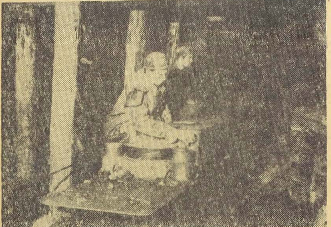
Mechanizacja prac na przedkach eksploatacyjnych - to podstawa zwiększonej wydajności pracy. Górnicy kopalni „Konrad II”: F. Gierak i W. Plecia przy obsłudze wręboladownicy współpracują z przenośnikiem pancernym. fot. A. Dabek
